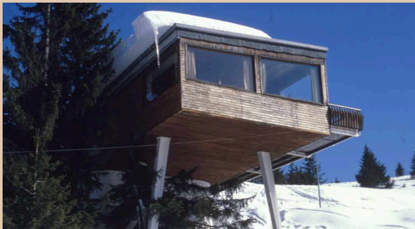
1987 – Chalet LANG, SAINT-BON-TARENTEISE/COURCHEVEL
