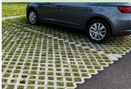
Stationnements végétalisés avec des dalles alvéolées – Aubière (63)
