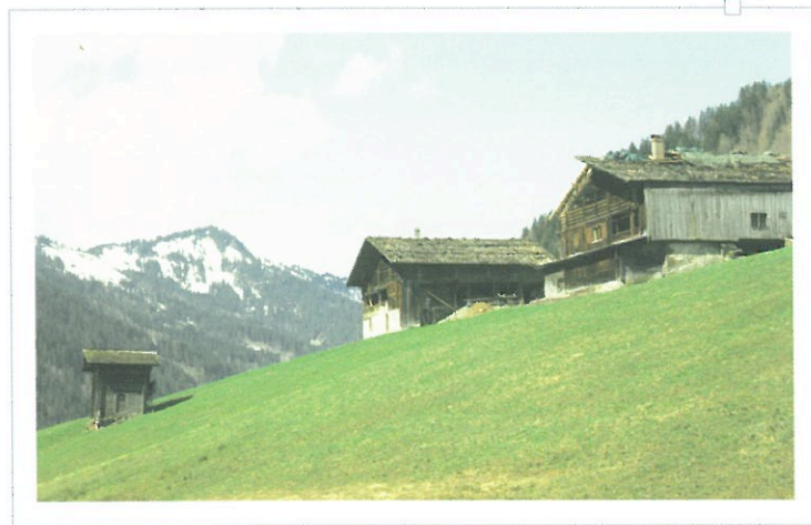
La resserre, dite « grenier », est construite à l'écart des maisons pour limiter les risques d'incendie. (Le Grand-Bornand, massif des Bornes, Haute-Savoie.)
