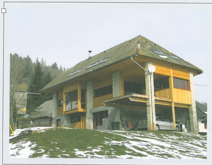
Vue d'ensemble de la grange début 2006. Manquent encore les garde-corps métalliques et l'escalier en bois de la terrasse extérieure, ainsi que les enduits de façade.
