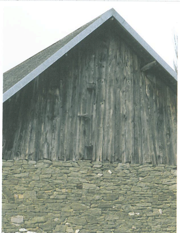
Mur d'une grange en pierres plates appareillées en lits horizontaux avec peu de mortier. (Massingy, Albanais, Haute-Savoie.)
