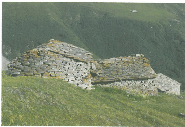
Bâtiments d'alpage couverts en lauzes. (Termignon, haute Maurienne, Savoie.)
