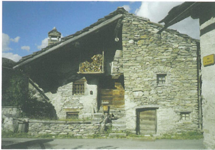
Maison de haute Maurienne entièrement construite en pierre. Le retrait d'une partie de la façade principale protège l'entrée et les balcons-séchoirs. (Bessans, Savoie.)
