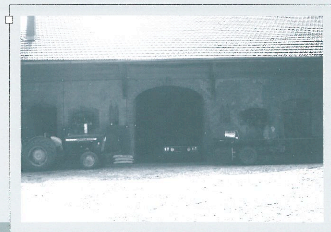
La ferme avant travaux.
