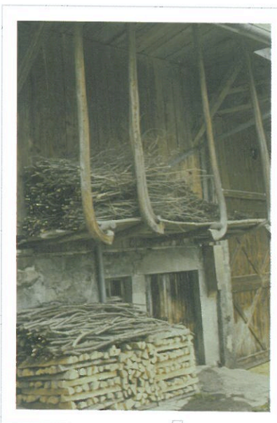
Exemple de tavalan, servant ici de support de rangement et de séchage pour le bois. (La Compote, Savoie.)
