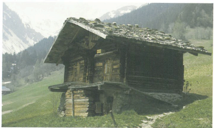
Grenier double juxtaposé. (Beaufort, Beaufortain, Savoie.)
