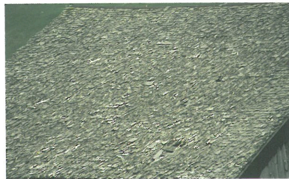
Toiture à forte pente couverte de tavaillons cloués sur un platelage (Mieussy, Faucigny, Haute-Savoie.)
