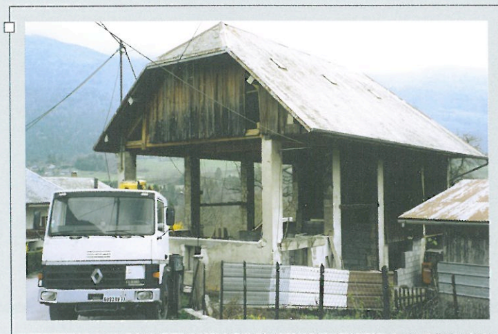
La grange au début des travaux. Le toit et les piliers sont conservés.
