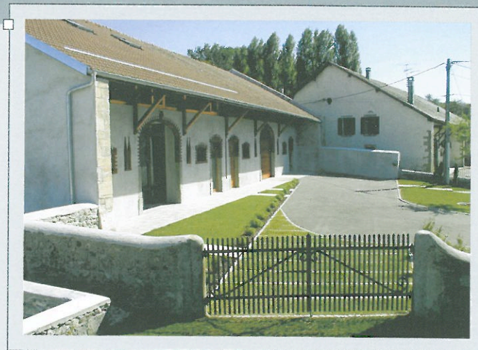
Vue de la façade principale (ouest) après les travaux.
