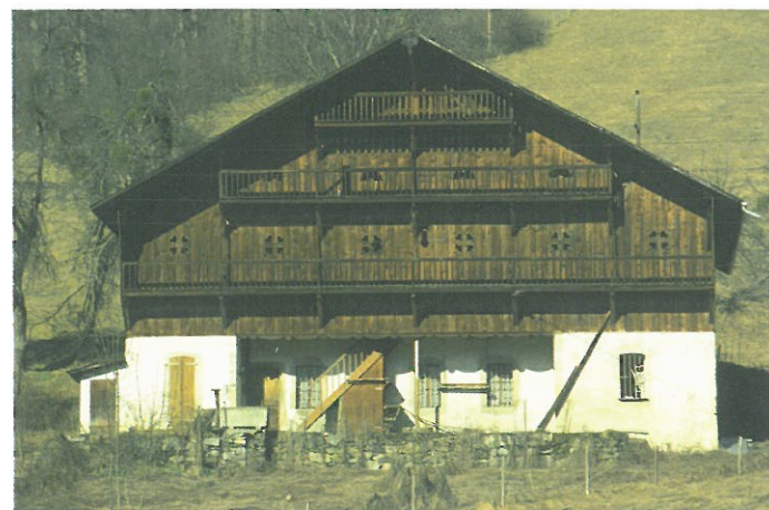
Ferme traditionnelle du Faucigny, réservant un volume important au fenil en partie haute. Les dessins des ventilations participent du décor du bâtiment. (Samoëns, Haute-Savoie.)
