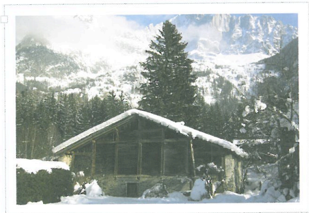
Cette ferme traditionnelle présente deux techniques constructives : la maçonnerie de pierre pour le soubassement et une charpente à colonnes fermée par un mantelage de bois pour la grange. (Chamonix-Mont-Blanc, haute vallée de l'Arve, Haute-Savoie.)
