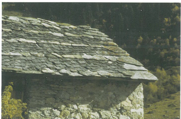
Exemple de couverture mêlant deux types de matériaux : le bois (ancelle) et la pierre (lauzes). (Pralognan-la-Vanoise, Tarentaise, Savoie.)
