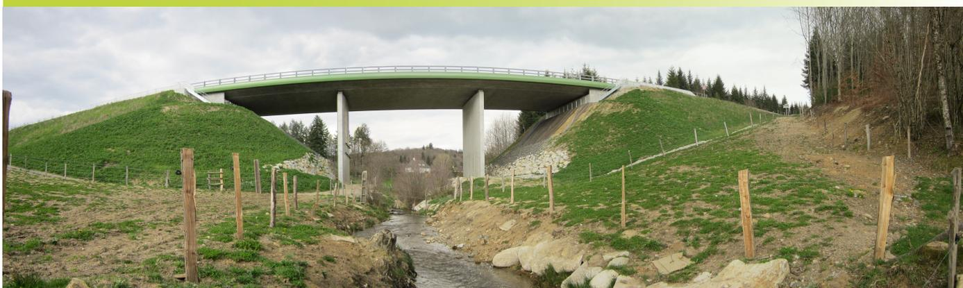
Franchissement du ruisseau de Branugues par un ouvrage d'art de type pont de 55m de long sur 15m de hauteur
