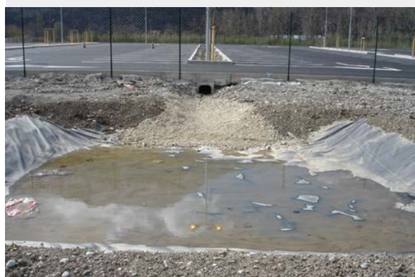
Passage sous un parking construit entre un site d'hivernage et un site de reproduction du crapaud calamite. Le passage se fait par une buse et des bordures ont été placées autour de l'espace de déplacement pour éviter que les crapauds n'accèdent au parking. La population de crapaud calamite a pu être maintenue grâce à ces aménagements.
