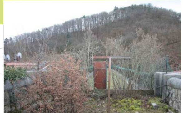
Etat du viaduc du Pertuiset avant travaux - Source FRAPNA
