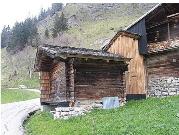
Figure 8 : Murs en madriers d'un grenier à la commune de la Giétaz.
