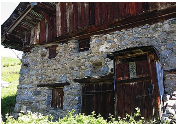
Figure 4 : Chalet d'alpage au lieu-dit de La Combe (Aime-la-Plagne). Les Hommes vivent dans la partie maçonnée.
