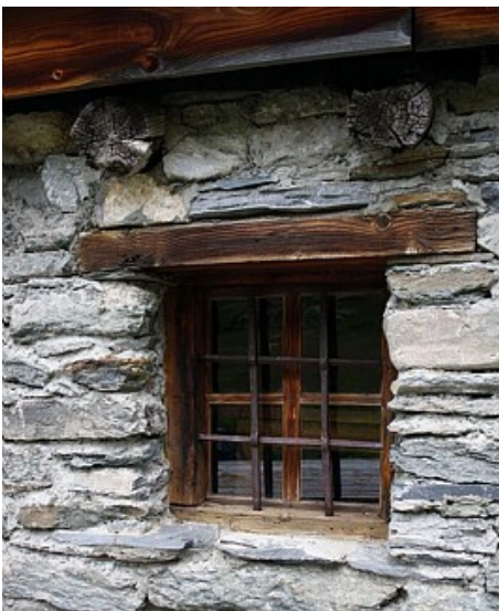
Figure 13 : Linteau en bois, chalet d'alpage au lieu-dit de Plume Fine (Val-Cenis).
