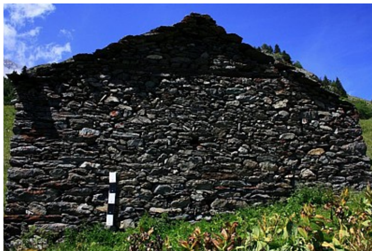
Figure 22 : Photographie avec repère graphique au lieu-dit de l'Allier (Val-Cenis, anciennement Termignon), source : ibid.
