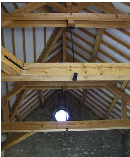
Figure 10 : Charpente de forme triangulaire ou en « ferme », bâtiment agricole à Bassens (Chambéry).
