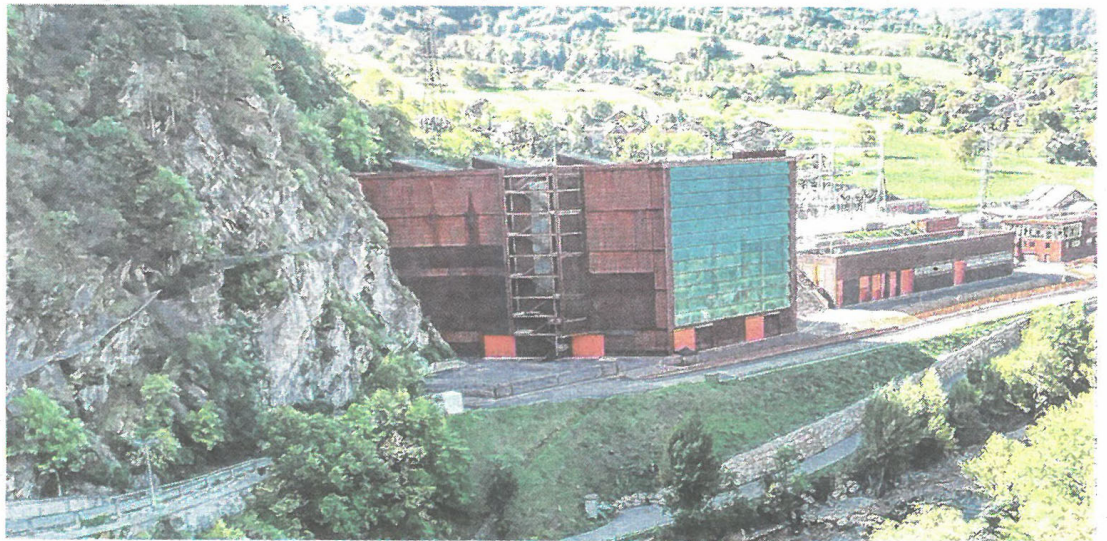
La Centrale hydroélectrique de La Coche a été sélectionnée en Savoie dans la catégorie construction publique, lieu de travail et de service (rénovation). Archives photo Le DL/S.M.
