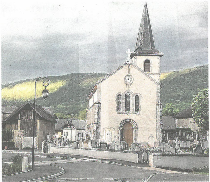
Avec la pose de la nouvelle croix en surplomb de la façade principale, les travaux de réfection du toit de l'église sont désormais terminés. Photo Le DL/B.M.
