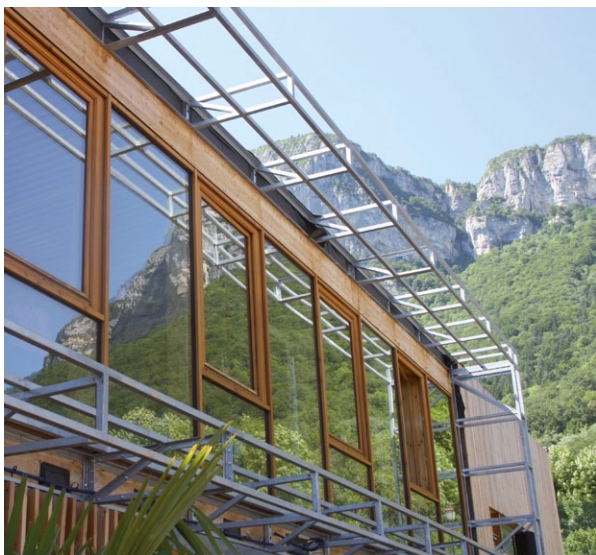
Mairie St-Jean d'Arvey - V.ROCQUES architectes
