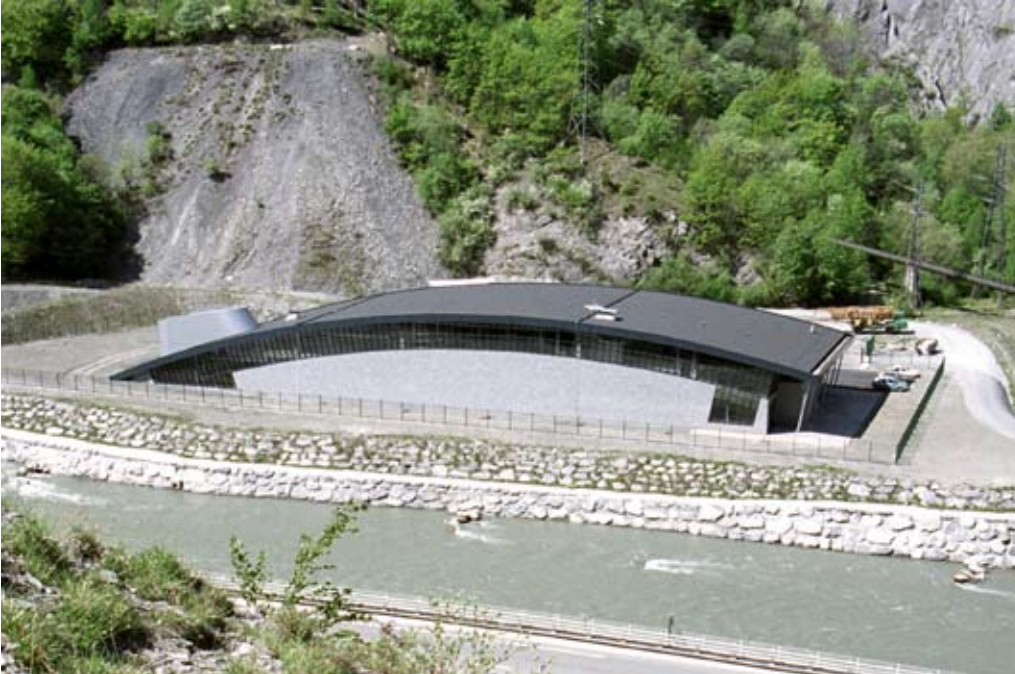
81, 82, 83 Station d'épuration, Valloire 2006 Jacques TERMIGNON, Architecte - Communauté de Communes Maurienne-Galibier
