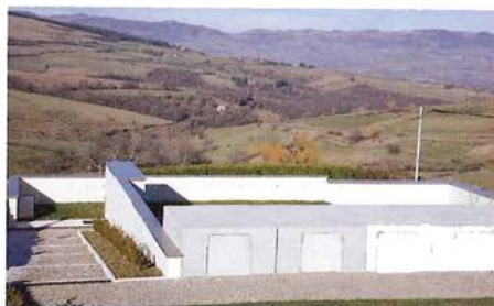
Les caveaux dans la nouvelle extension.
