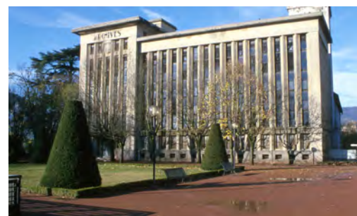
▲ CHAMBÉRY - Anciennes archives Label patrimoine du XX e siècle
