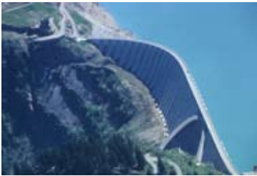
● BEAUFORT-SUR-DORON Barrage de Roselend - patrimoine du XX e siècle (site inscrit)
