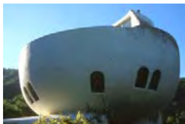
★ APREMONT Architecture du XX e siècle. Pascal Hausermann, architecte (sans protection)
