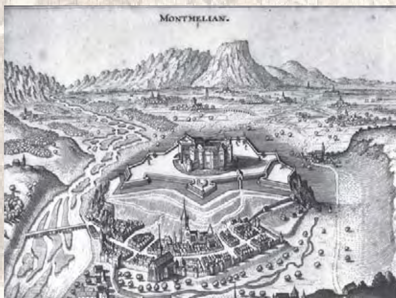
Montmélian au XVII e siècle, verrouillant la confluence de la Combe de Savoie et de la Cluse de Chambéry
