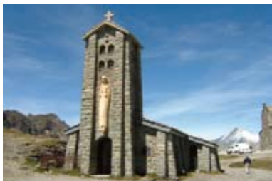
● BONNEVALSUR-ARC (Col de l'Iseran 2 769 m) Chapelle Notre-Dame-de-Toute-Prudence construite en 1939 (site classé le 05/10/1939)
