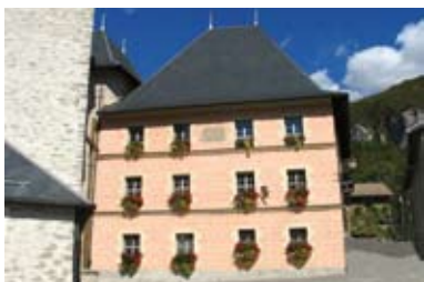
SAINT-MARTIN-LA-PORTE Maison Blanche (patrimoine non protégé)
