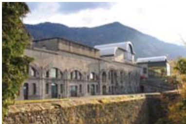
AITON Ancien fort 1876 (non protégé)
