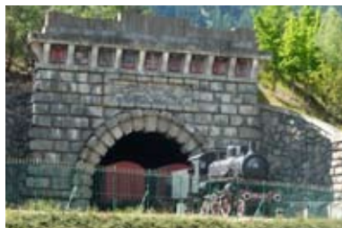
★ MODANE Entrée monumentale du tunnel ferroviaire du Fréjus (monument inscrit le 27/03/1926)
