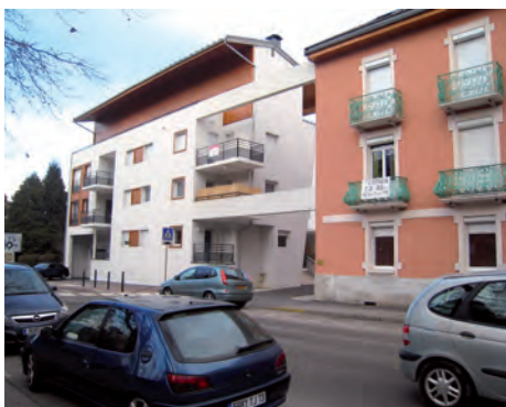
Alignement de façades anciennes et nouvelles
