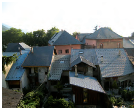
Intersections multiples de pans de toitures à Conflans
