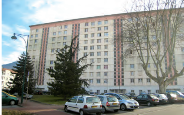
Percements systématiques des années 60
