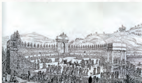
Pose en 1824 de la Pierre du Roy pour l'endiguement de l'Isère
