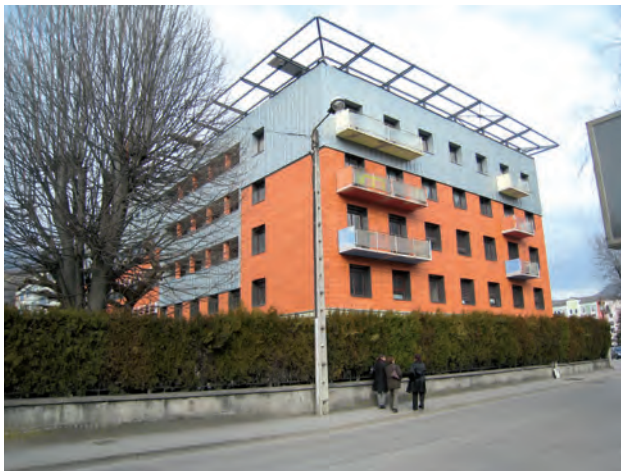
Volume cubique à l'aspect transformé par l'ajout de vêtements, de balcons et d'une attique
