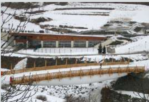
Un pont sous-tendu par une membrane basse pression avec Air-Light et Charpente-Concept. Une première mondiale - Lanslevillard - Val Cenis
