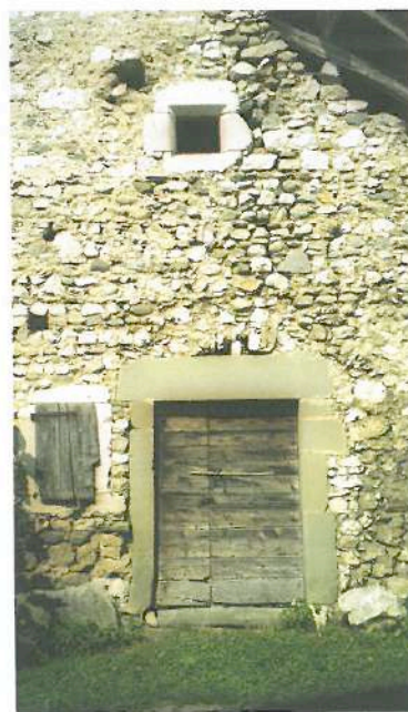
Les murs de cette grange sont constitués de moellons irréguliers. Les ouvertures sont encadrées de pierres taillées (calcaire et grès argileux). (Le Bourget-du-Lac, Savoie.)
