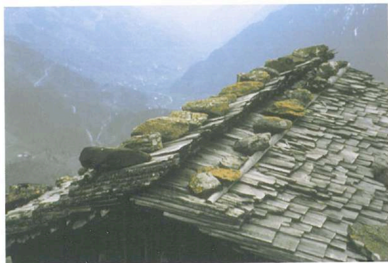
Toiture à faible pente couverte d'ancelles maintenues par des perches et des pierres. (Beaufort, Beaufortain, Savoie.)
