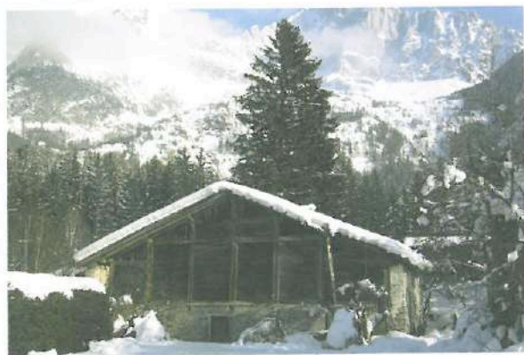
Cette ferme traditionnelle présente deux techniques constructives : la maçonnerie de pierre pour le soubassement et une charpente à colonnes fermée par un mantelage de bois pour la grange. (Chamonix-Mont-Blanc, haute vallée de l'Arve, Haute-Savoie.)
