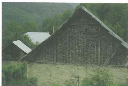
Grange fermée par un clayonnage de branches d'aulne tressées, ou arcosses. (Arvan-Villard, Saint-Alban-des-Villards, Savoie.)
