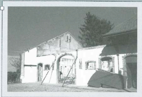
Vue du chantier de la première phase des travaux : les murs principaux sont conservés mais la toiture est déposée.
