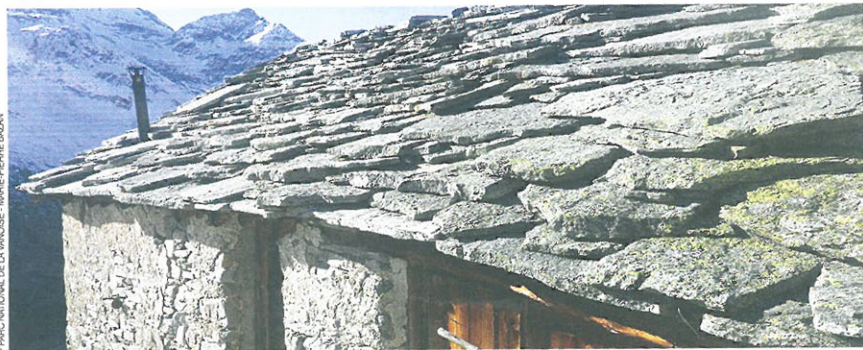
Les toits de Lauzes, typiques de la Vanoise, mais changeant de type d'une vallée à l'autre
