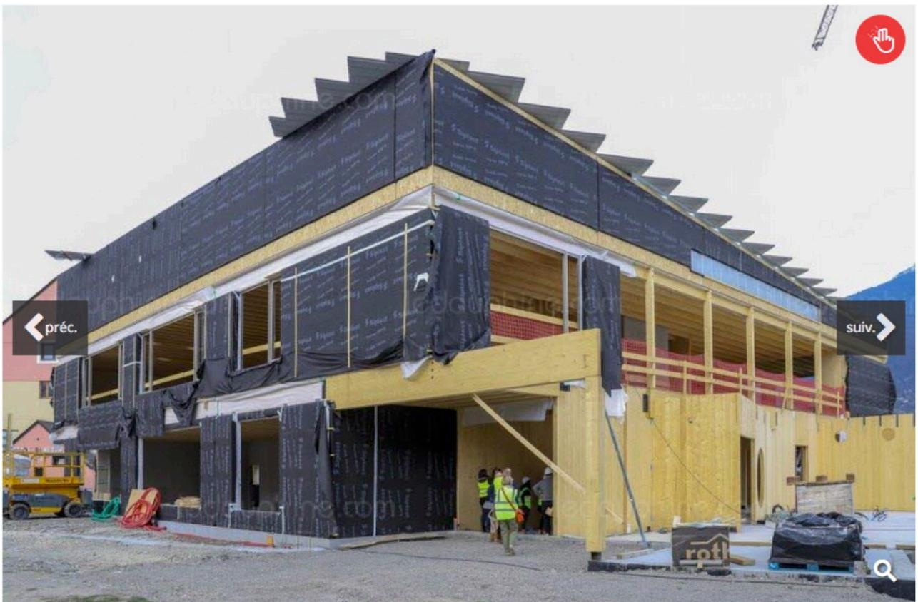
La construction se présente en une structure mixte, composée de bois et de béton. Photo Le DL/Ch.D.
