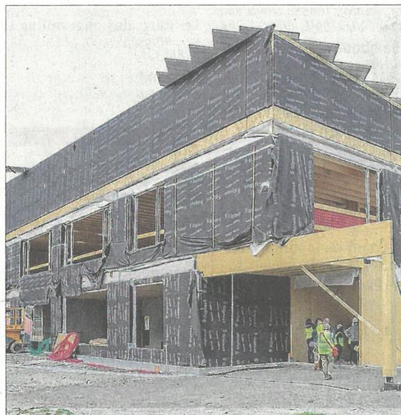
La construction se présente comme une structure mixte composée de bois et de béton. Photo Le DL/C.D.
